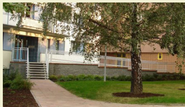
Obr. Ukázka bezbariérové úpravy vstupu do panelového domu v podobě dodatečného vybudování rampy (sídlště Fifejdy, Ostrava)
