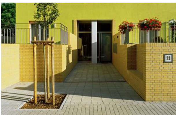
Obr. Referenční ukázka řešení vstupu do domu (přestavba panelových domů v Halle-Neustadt, Stefan Forster Architekten)
