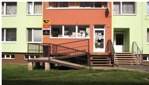
obr–32 Pobočka pošty v parteru panelového domu (Liščí Vrch, Most).
