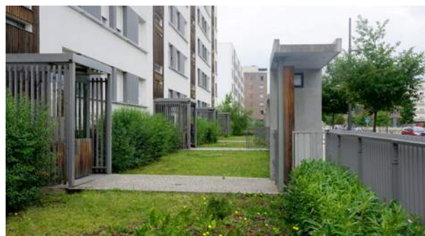
obr-63 Revitalizace předprostoru panelového domu (Vaulx-en-Velin, Lyon).
