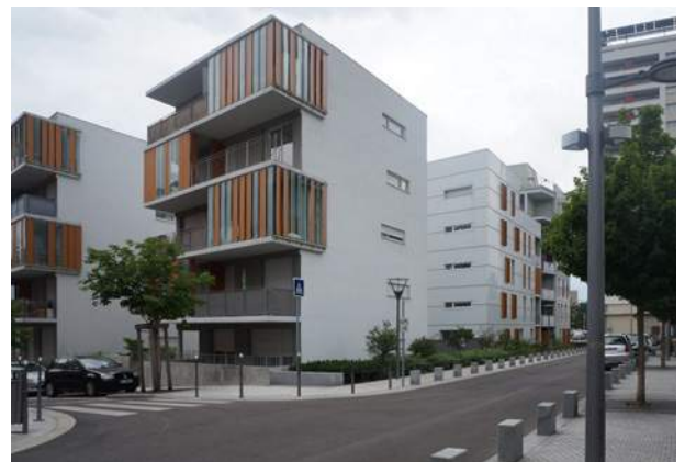
obr-21 Novostavby bytových domů v místě původních panelových domů v rámci revitalizace sídliště (Vaulx-en-velin, Lyon, Francie).
