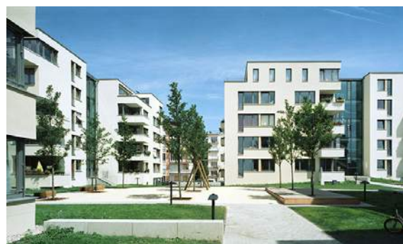
2) Pohled do prostupného vnitrobloku © Henning Koepke
