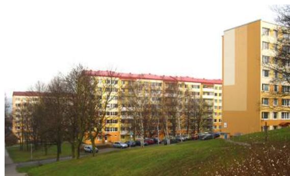
2) deskové panelové domy ve svahu
