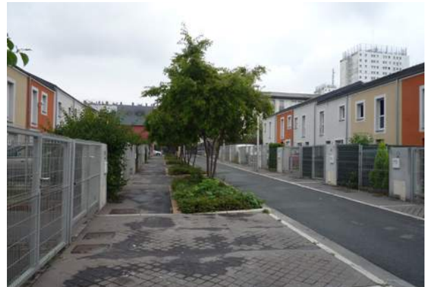
obr-19 Dostavba řadových domů v rámci projektu revitalizace sídliště (Amiens-Nord, Amiens, Francie).
