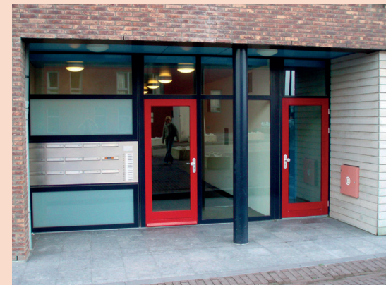
Ilustrativní fotografie č. 5.8 – Vstup do domu – dobré řešení
