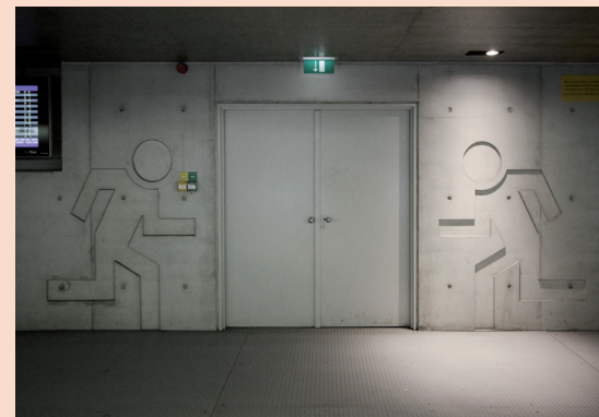
Ilustrativní fotografie č. 7.11 – Reliéfní kontrast usnadňuje orientaci v prostoru a upozorňuje na únikový východ v budově
