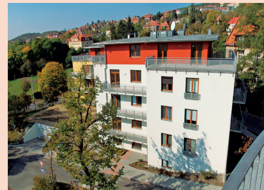
Ilustrativní fotografie č. 4.6 – Umístění sociální služby provozované v běžné bytové zástavbě
