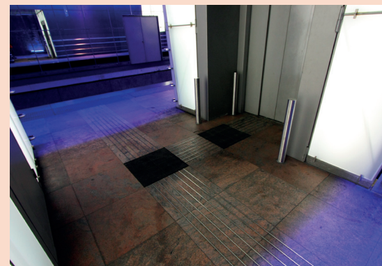
Ilustrativní fotografie č. 7.12 – Kontrast jasu – kontrastem intenzity a barvy nasvícení lze akcentovat důležitá místa a prostory, jako např. vstup do výtahu
