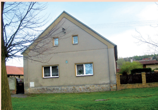
Ilustrativní fotografie č. 5.6 – Příklad vesnického rodinného domu před rekonstrukcí
